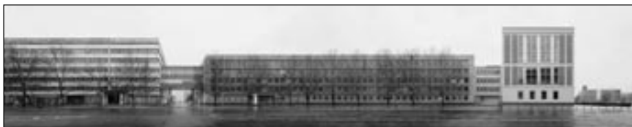
Arwed Messmer, Breite Strasse 1-11, Kanzleiflügel des Staatsratsgebäudes mit der Überbrückung der Neumannsgasse zum ehemaligen Ministerium für Bauwesen der DDR, 17. März 2006 (O.i.F)
